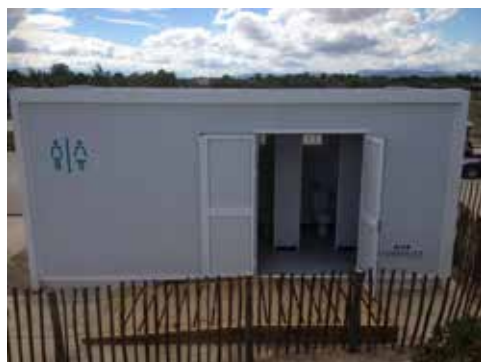
Blocs sanitaris Blocs sanitaires
